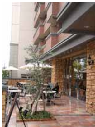
高層住宅の1階のカフェテリア
