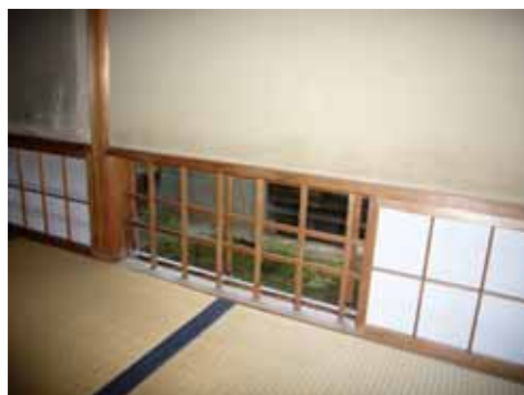
廊下に設けられた地窓から光と風が入る
