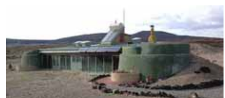
講演で紹介された自然循環型建築「earthship」 (earthship hpより転載)
