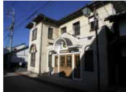
旧八幡郵便局 NPO法人ヴォーリス建築保存再生運動「一粒の会」 が保存再生を行っているヴォーリス建築
