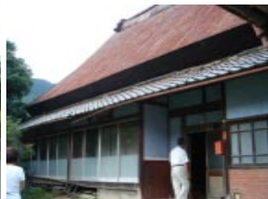
活用されていない民家
