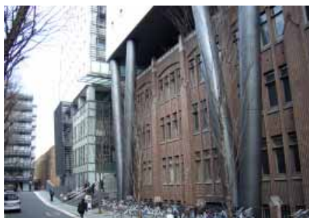
工学部2号館外部 既設との接続部
