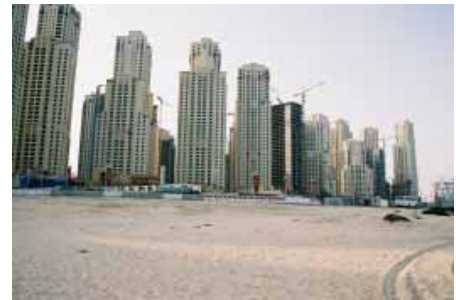
アラビア湾に面する海岸沿いに林立するプロジェクト。未だ入居者、利用者はひとりもない。見える範囲は全て、建設中。
