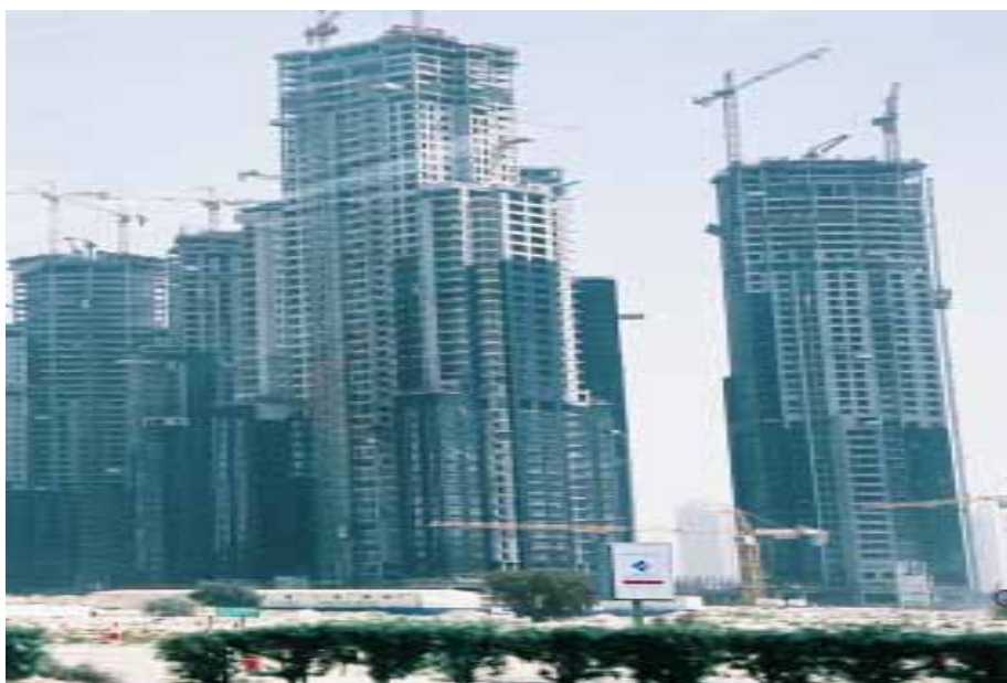
車中から見る大規模開発の様子。
