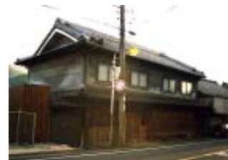
国道24号線に面した池永家
