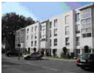
図9：研修施設脇に設けられた集合住宅
