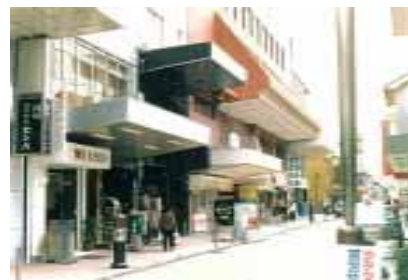
豎町商店街 (金沢市) 統一的な庇
