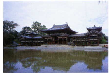
東側の阿字池から鳳皇堂と宝物館入口部分(左奥)を見る。
